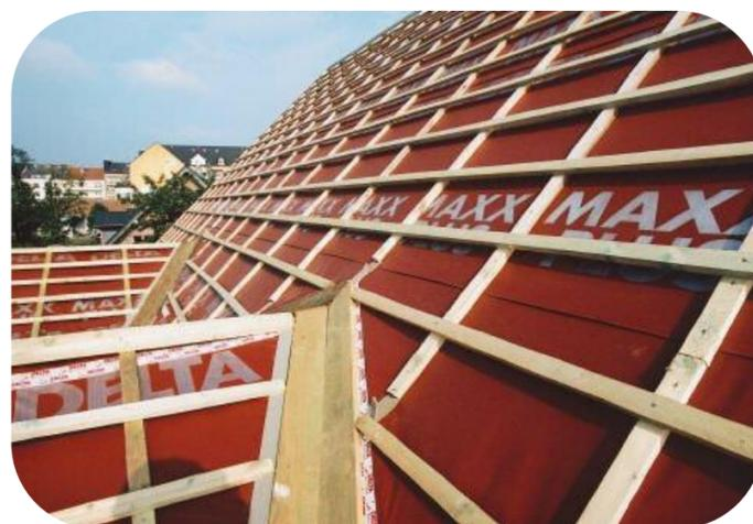
Гидроизоляционная мембрана на стропилах
