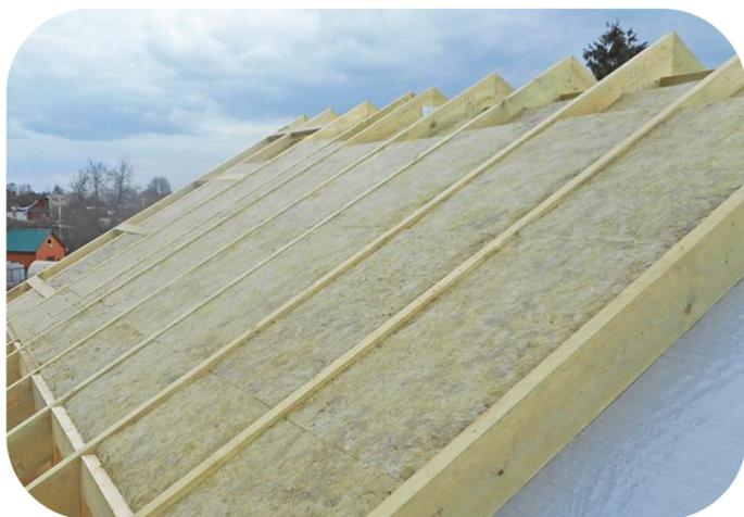
Герметичная укладка без щелей и зазоров
