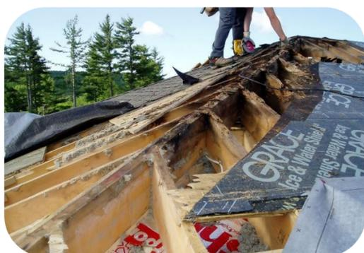
Гниение каркаса крыши и утеплителя
